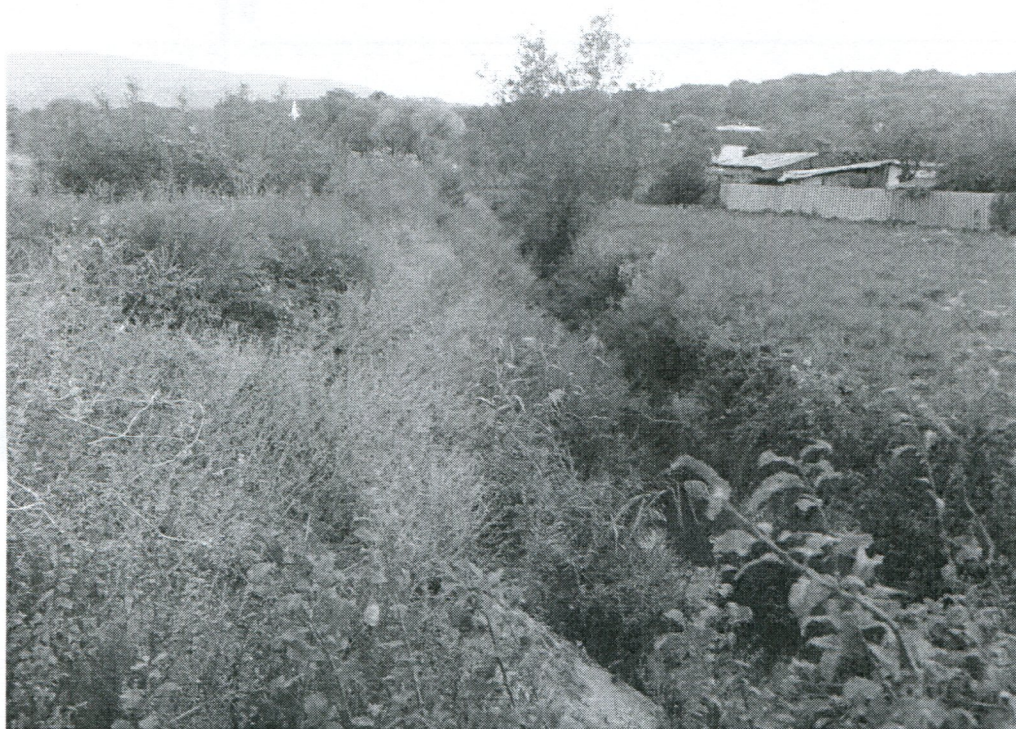
Obr. X.3. Kanál A (ev. č. 5 402 013 001)
